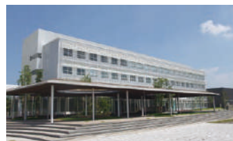
技術開発交流センター (5号館)
