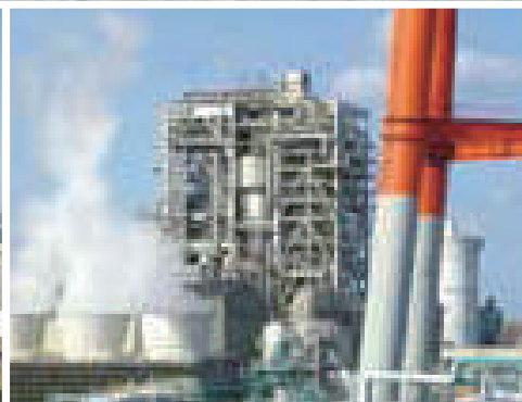
石炭火力発電所
