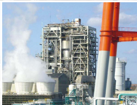
石炭火力発電所
