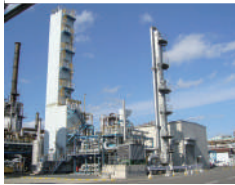
工業ガス製造設備
